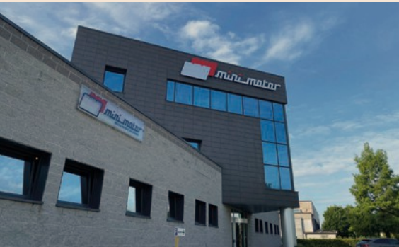
Esterno dello stabilimento
