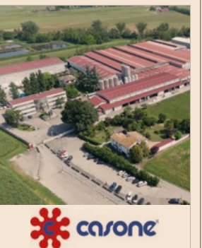
Esterno dello stabilimento
